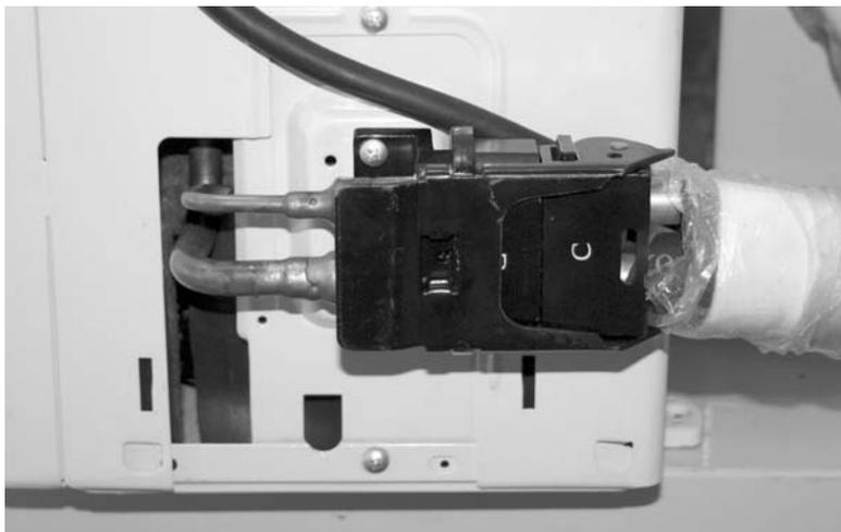
Réaliser alors la connexion électrique entre les unités.
